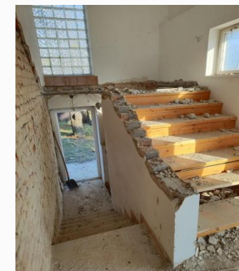
Realita – schodiště v přestavbě
