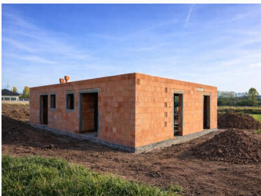
Realita – zabetonování stropu
