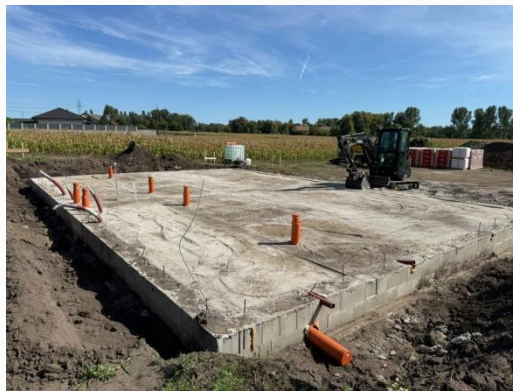
Realita – zabetonování základové desky
