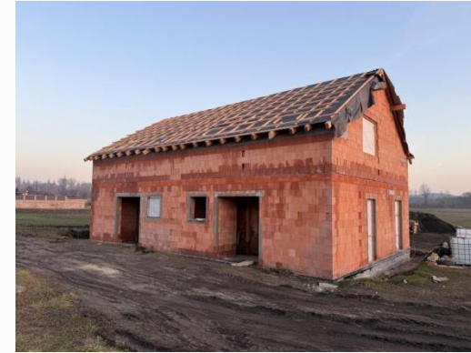
Realita – realizace střechy
