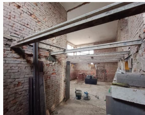
Realita – ocelové nosníky
