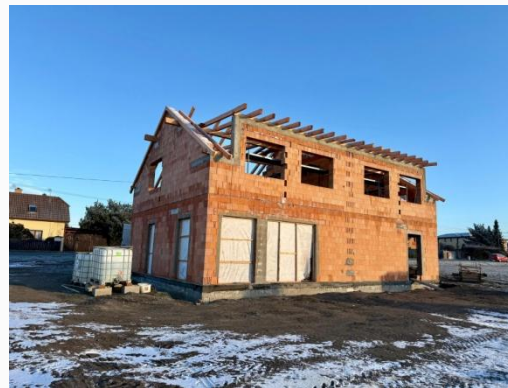
Realita – stavba krovy
