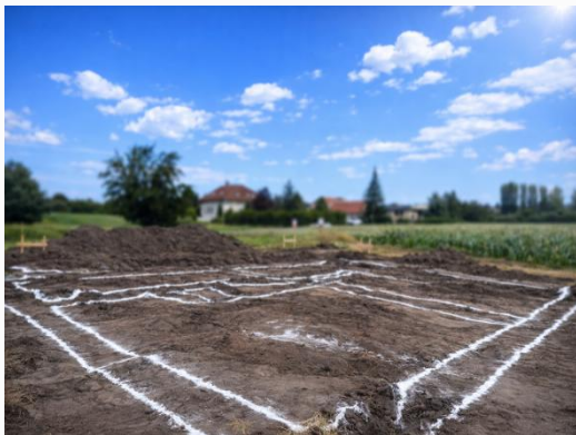
Realita – vytyčení pozemku, označení výkopů
